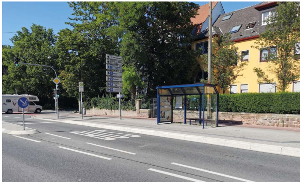
Abbildung 24: Haltestelle „Hirschgraben“ (stadtauswärts) – barrierefreier Ausbau
