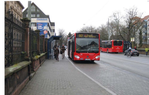
Abbildung 18: Haltestelle „Postgraben“ – kein niederflurgerechter Ausbau, Bus kann deshalb nicht spaltfrei an den Bordstein anfahren
