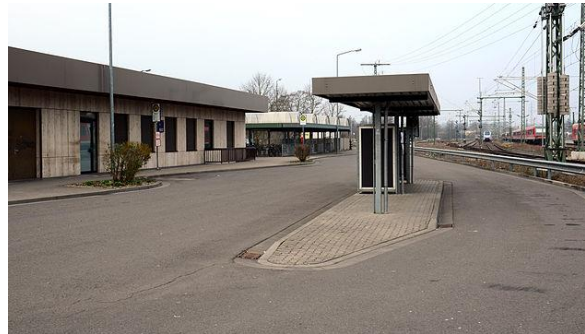
Abbildung 25: Bussteige Bahnhof Germersheim
