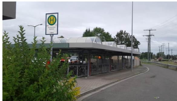
Abbildung 26: Fahrradabstellanlage Bahnhof Germersheim
